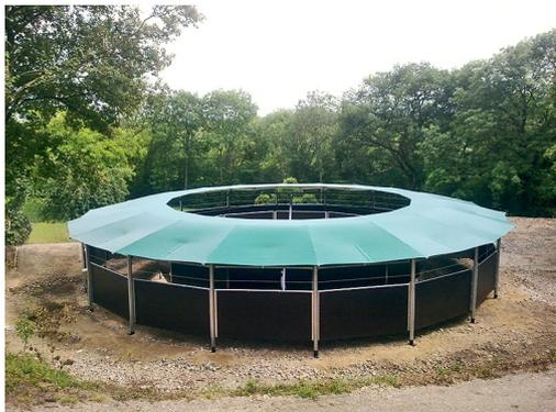
De 14 à 20 mètres de diamètre, ce marcheur pour chevaux est un véritable outil de travail. Sa structure légère, démontable, est composée de profilés métalliques. La couverture est en bâche plastifiée. La structure est ancrée par des piquets hélicoïdaux, par conséquent, aucune fondation n'est requise.
